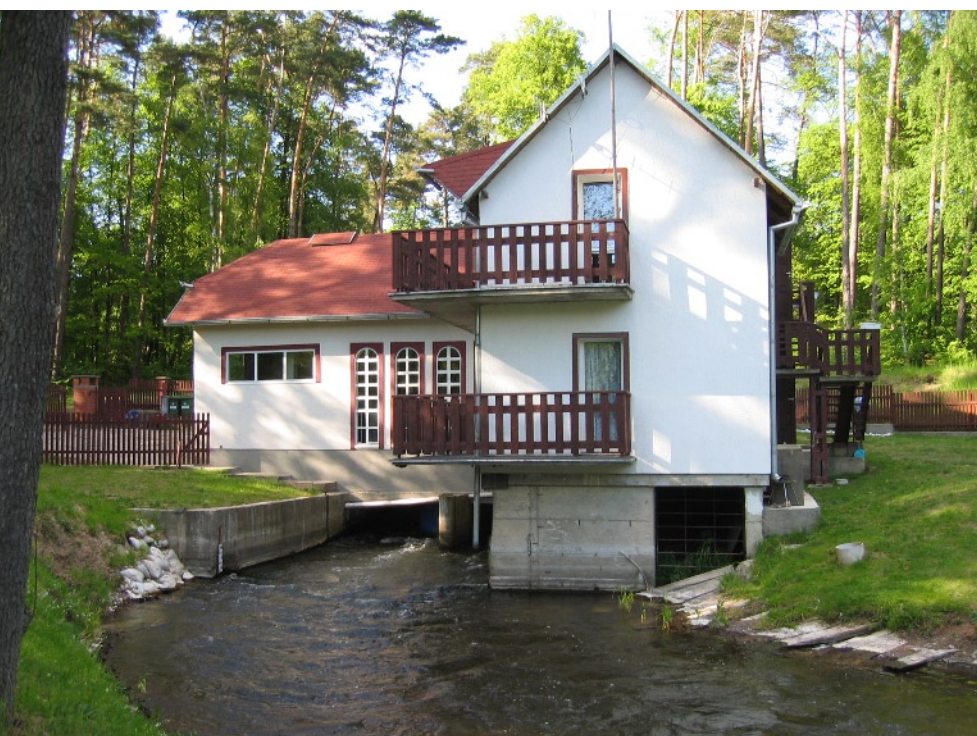
Fot. Elektrownia wodna Zielonka
