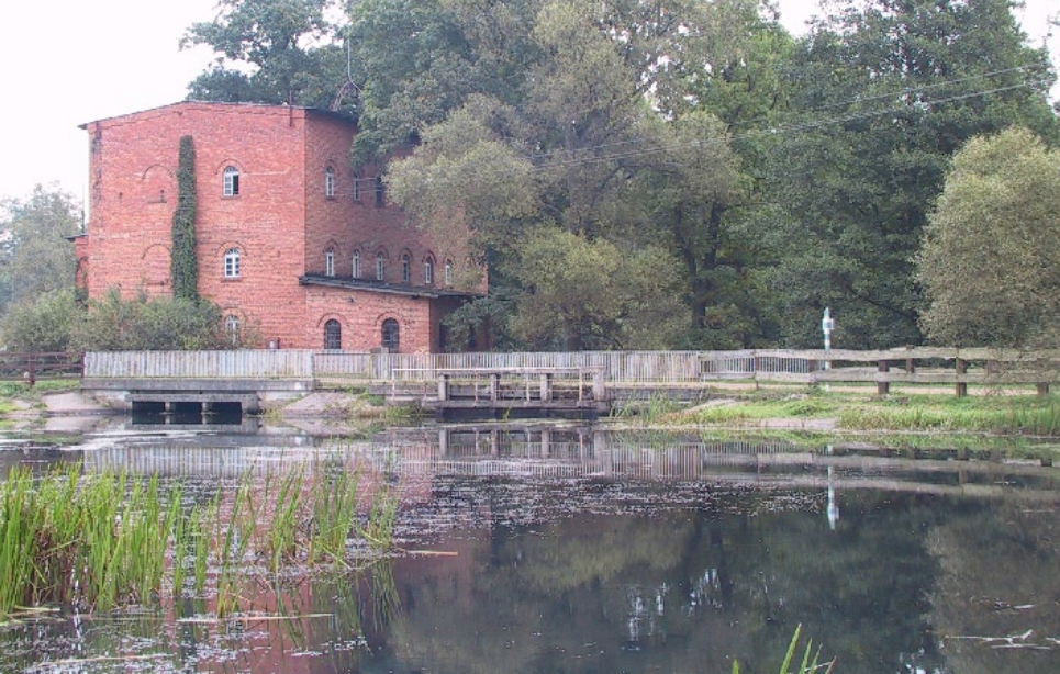
Fot. Elektrownia wodna Piła Młyn
